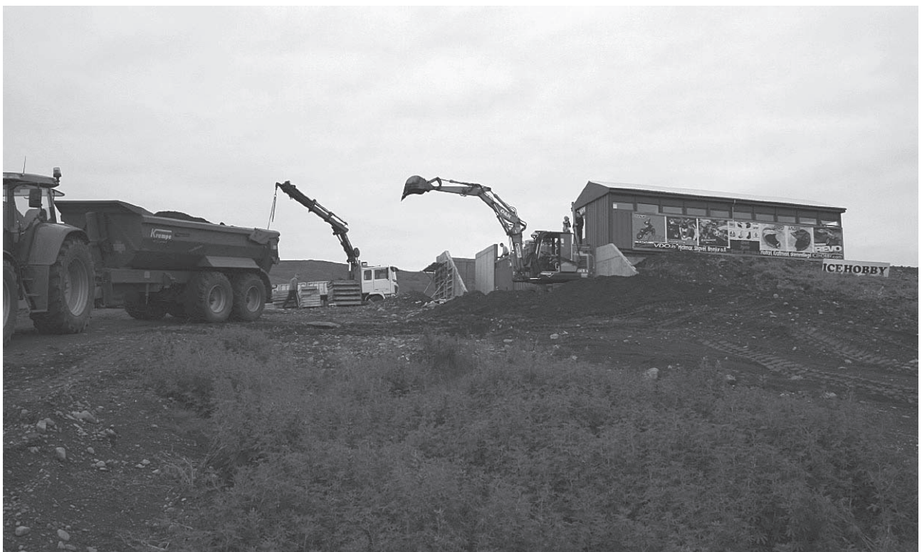
Jarðvegsvinna og steypa.
